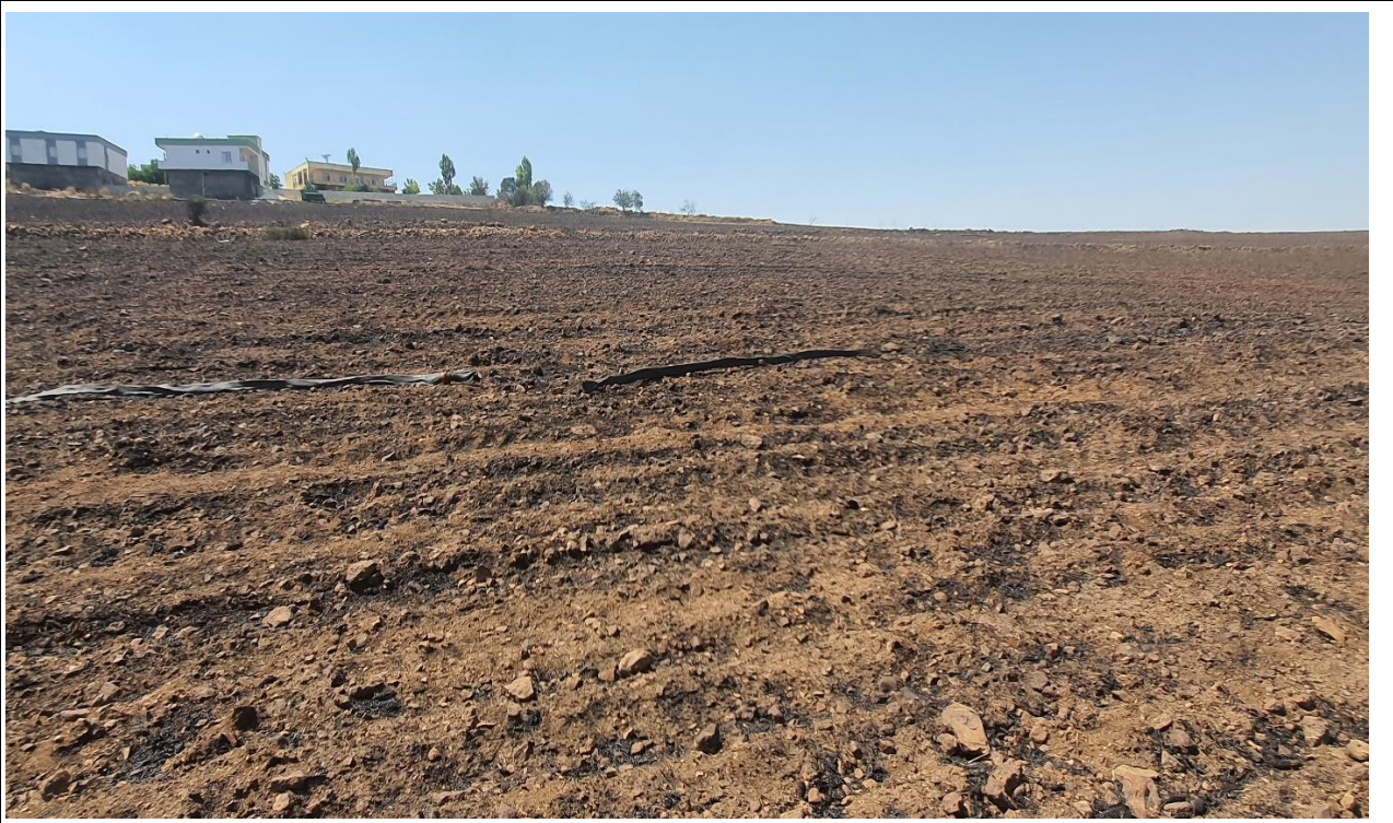
Arazi Üzerinde Yanmış Sulama Boruları
